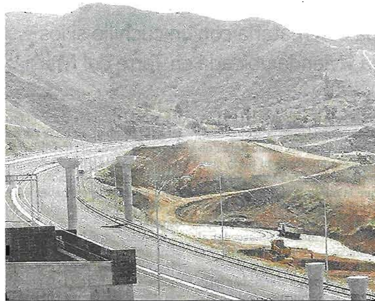
Uno de los tramos de la hiperronda en construcción.
