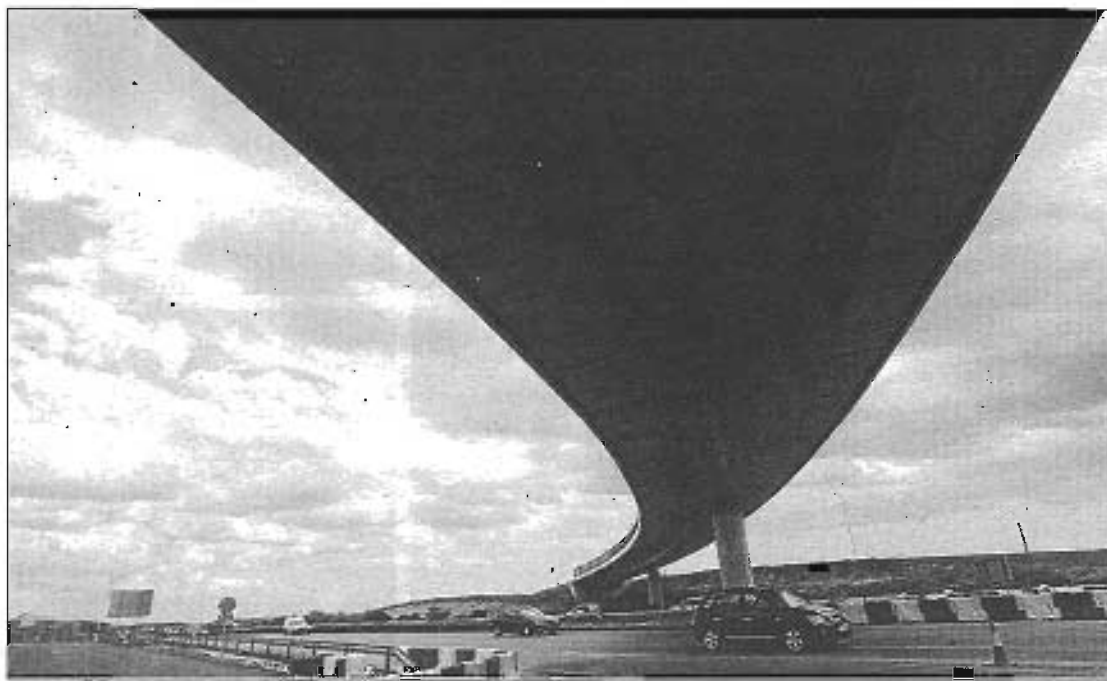
Obras de la futura hiperronda a la altura del Centro de Transporte de Mercancías (CTM). ARCINIEGA
